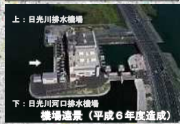
日光川河口排水機場
