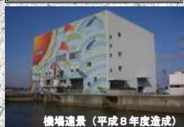
尾西排水機場
