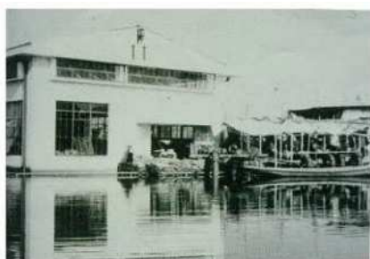
浸水により機能を失った日光西排水機場 (現 善太第3排水機場)
