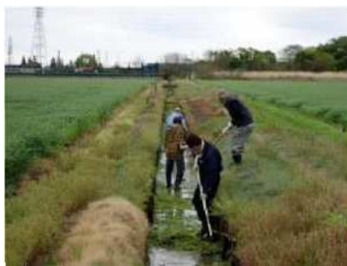
排水路の泥上げ
