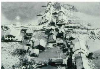
浸水により機能を失った孫宝排水機場
