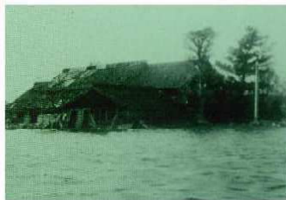
家屋浸水状況 (旧 十四山村:現 弥富市)
